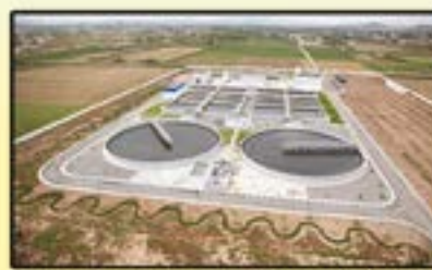
Station d'épuration des Eaux Usées - Grand Nador
