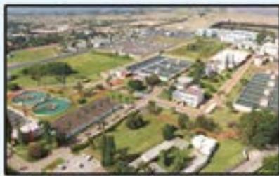
Station de Traitement des Eaux de Bouregreg - Rabat
