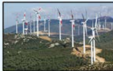
Parc Eolien de Tanger
