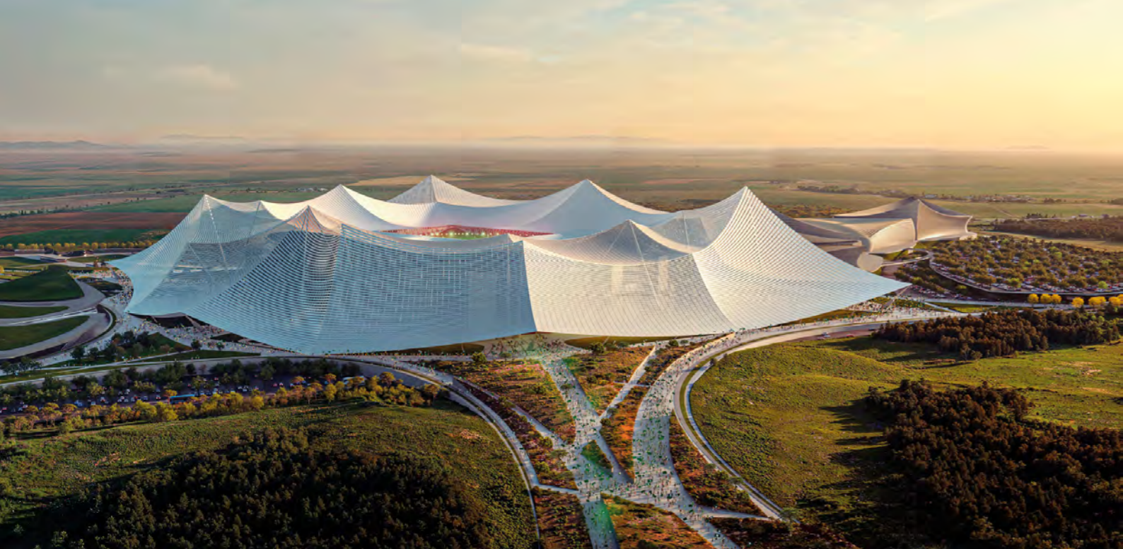
Avec une capacité record de 115 000 places, le Grand Stade Hassan II est appelé à devenir le plus grand stade de football au monde. Conçu pour la Coupe du Monde 2030, il verra le jour à Benslimane, à quelque 40 km au nord de Casablanca. Le projet est signé par l'architecte marocain basé à Paris Tarik Oualalou, fondateur du cabinet OUALALOU + CHOI.
